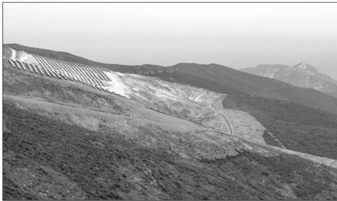
Sur la ligne de crête dominant la vallée de Morteda, un site choisi pour accueillir le parc de Meria/Morsiglia
